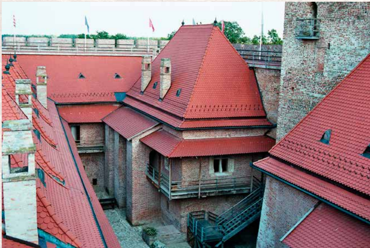
A várudvar az északeleti palotaszárnyal
