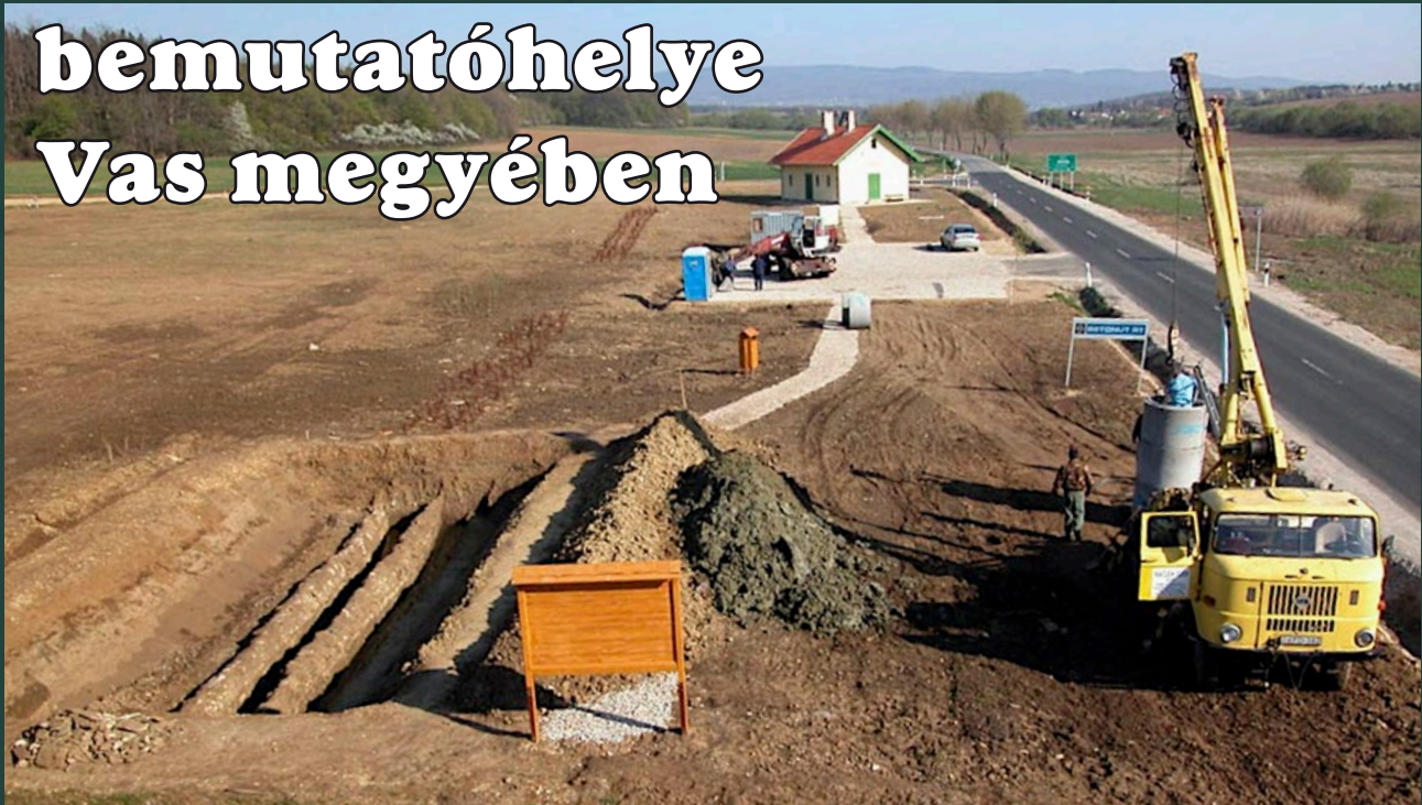
A vízvezeték a bemutatóhely kialakítása közben. Háttérben a parkoló és a vasútállomás már felújított épülete (fotó: Ilon Gábor, 2005)
