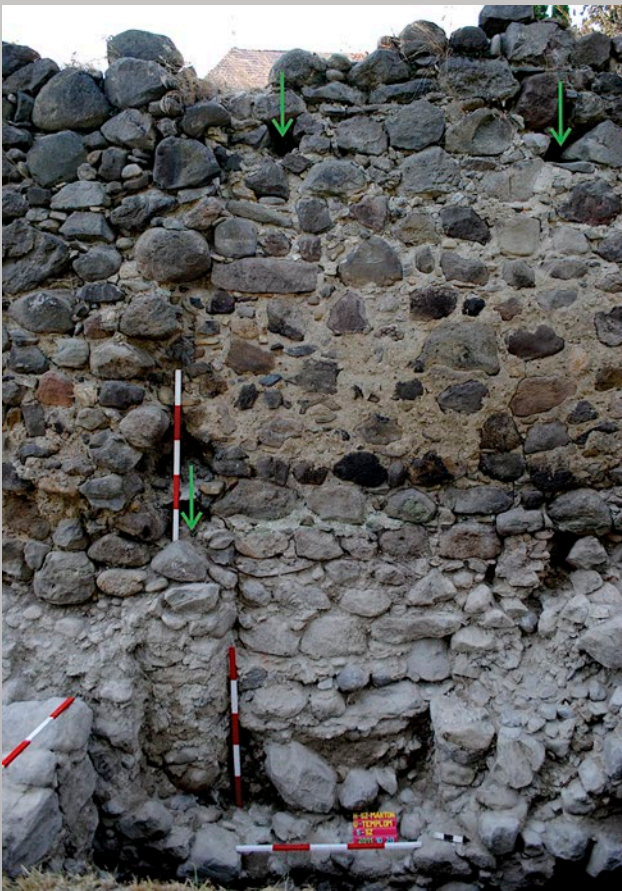
A keleti védőtornyonyomata a várfal külső oldalán, 2011 – zölddel jelölve a torony belső szintjeinek gerendafészkei (a szerző felvétele)
