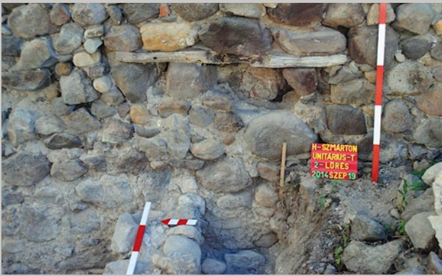
A 2. számú lőrés, melyet később elzártak a keleti kőépület belső osztófálával, 23. szelvény, 2014 (a szerző felvétele)
