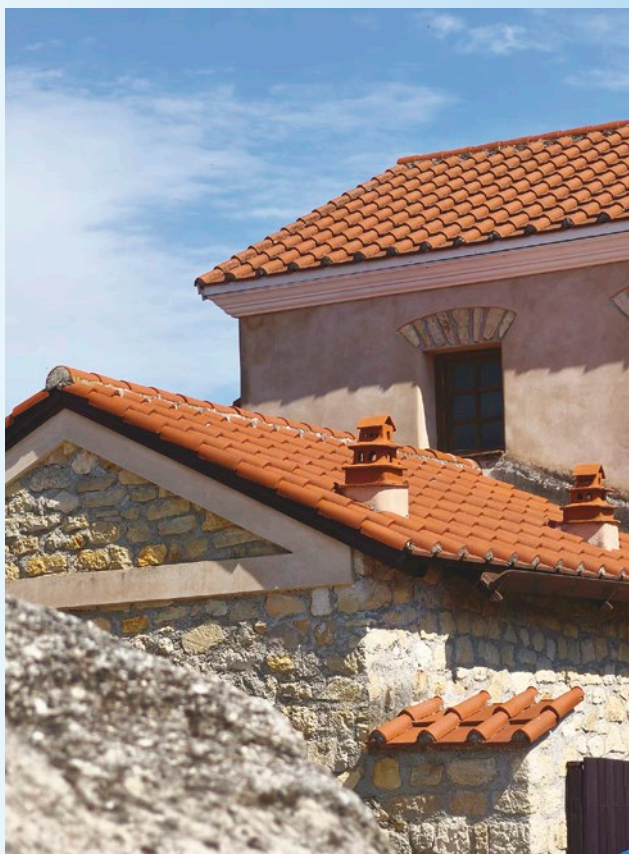
A Lucius-ház tetőszerkezete az ún. világítótorny-modellekként ismert terrakotta kéménydíszekkel (a szerzők felvétele)
